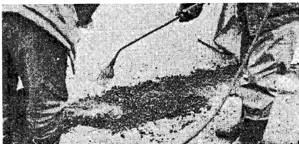
写真-5 混合物の舗設
