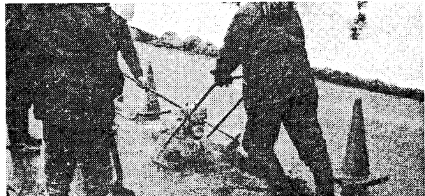
写真-6 締め固め
