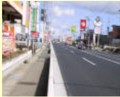
密粒度アスファルト舗装
