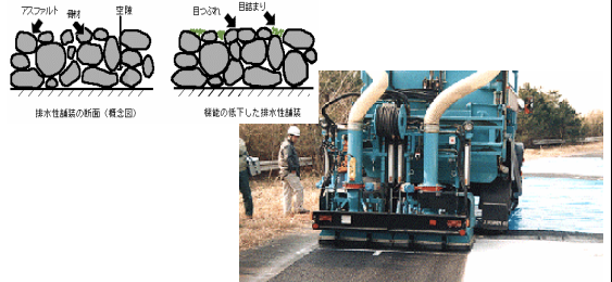
空隙詰めし物質の除去作業
