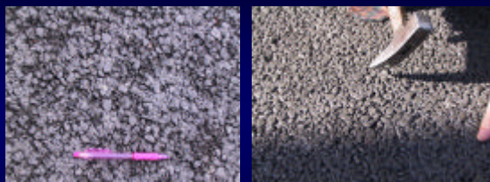
-モルタルは硬くはがりにくい (水でぬらすと若干すべりやすい)
