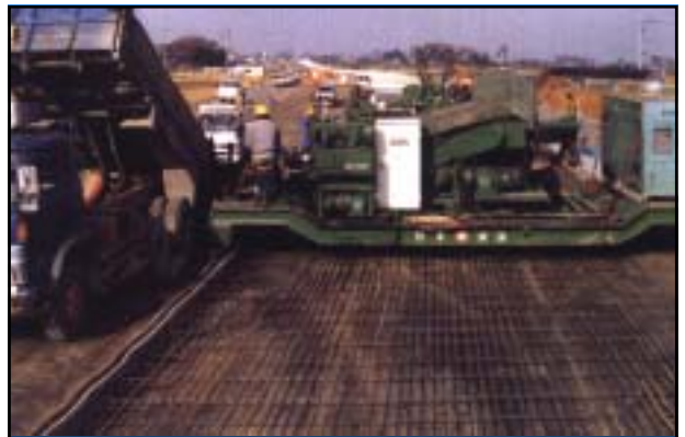
連続鉄筋コンクリート舗装 (CRCP) の施工
