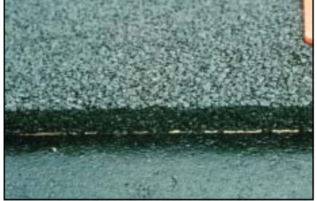
排水性舗装の透水層
