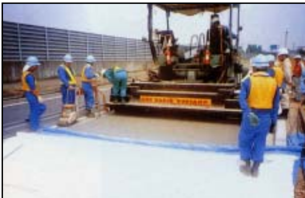
透水性転圧コンクリート舗装
