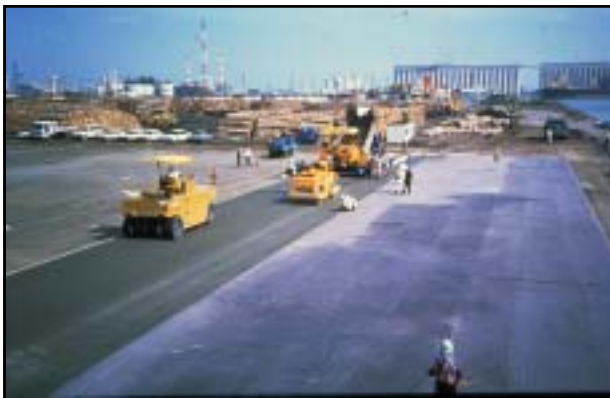
ヤードの施工
