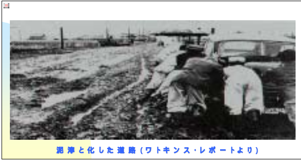
泥濘と化した道路 (ワトキンス・レポートより)
