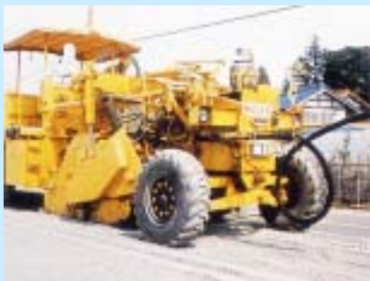
路上再生CAE安定処理路盤工法の施工状況
