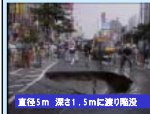
東京都銀座の道路陥没 (昭和63年)
